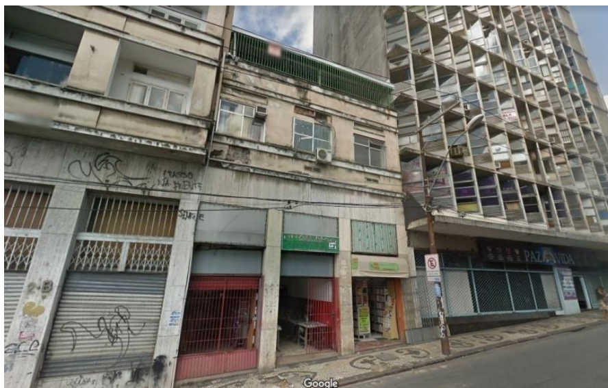
Imagem 4 – Imóvel a Rua Carlos Gomes, 26, Salvador-BA em 2020.
